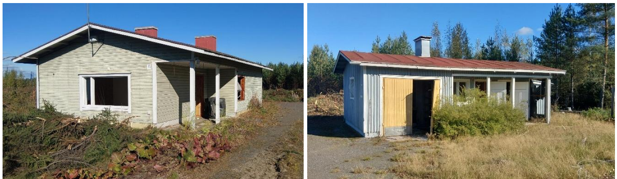
Kuva 3-23. Oikotie 11:n asuinrakennus ja talousrakennus. (Harjavallan kaupunki syyskuu 2025)
