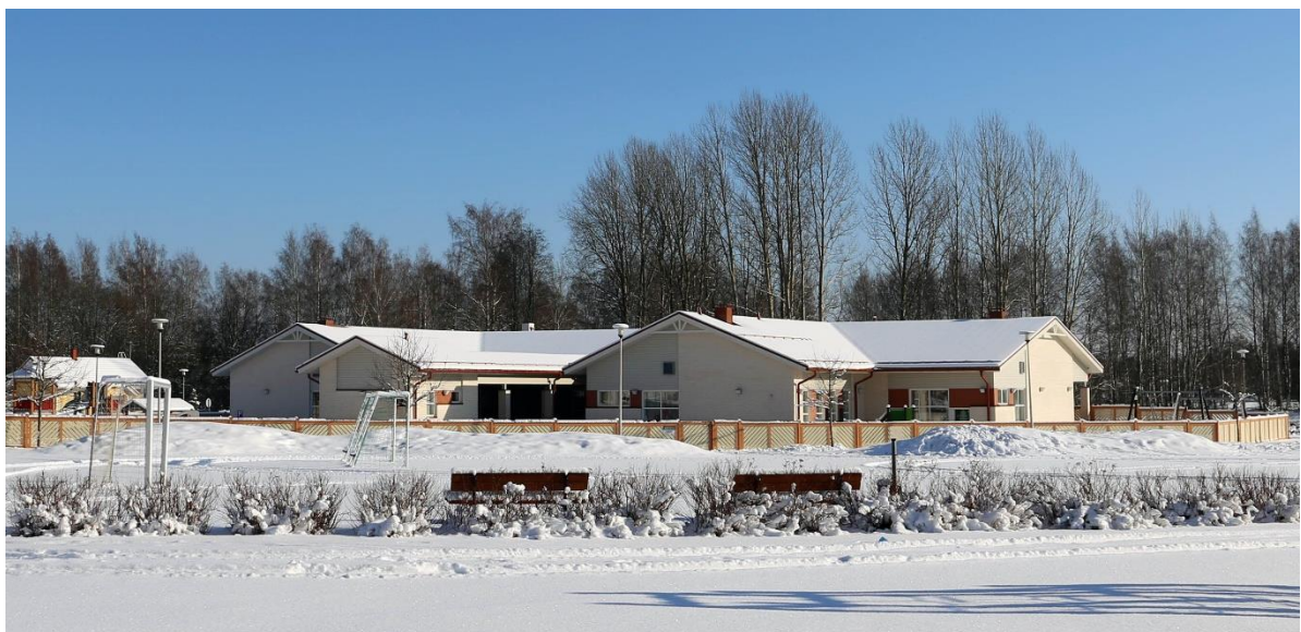
Kuva 3-13. Näkymä alakoulun pihasta kohti päiväkotiä. (Ramboll 2023)
