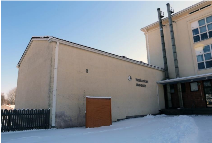
Kuva 7-1. 1949 valmistuneen kansakoulun voimistelusalisiiven pohjoispääty sekä julkisivu länteen Myllykadun suuntaan (Ramboll 2023).
