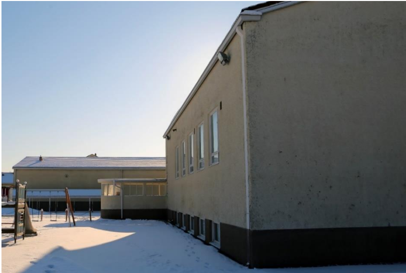
Kuva 7-2. 1949 valmistuneen kansakoulun voimistelusalisiiven pohjoispääty sekä pihan puoleinen julkisivu itään ja pihan puoleinen katos (Ramboll 2023).
