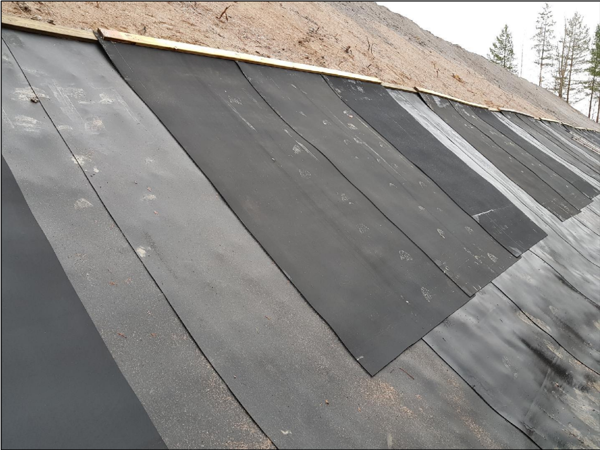
Kuva 5. Kumimattorakenne taustavallin pinnassa
