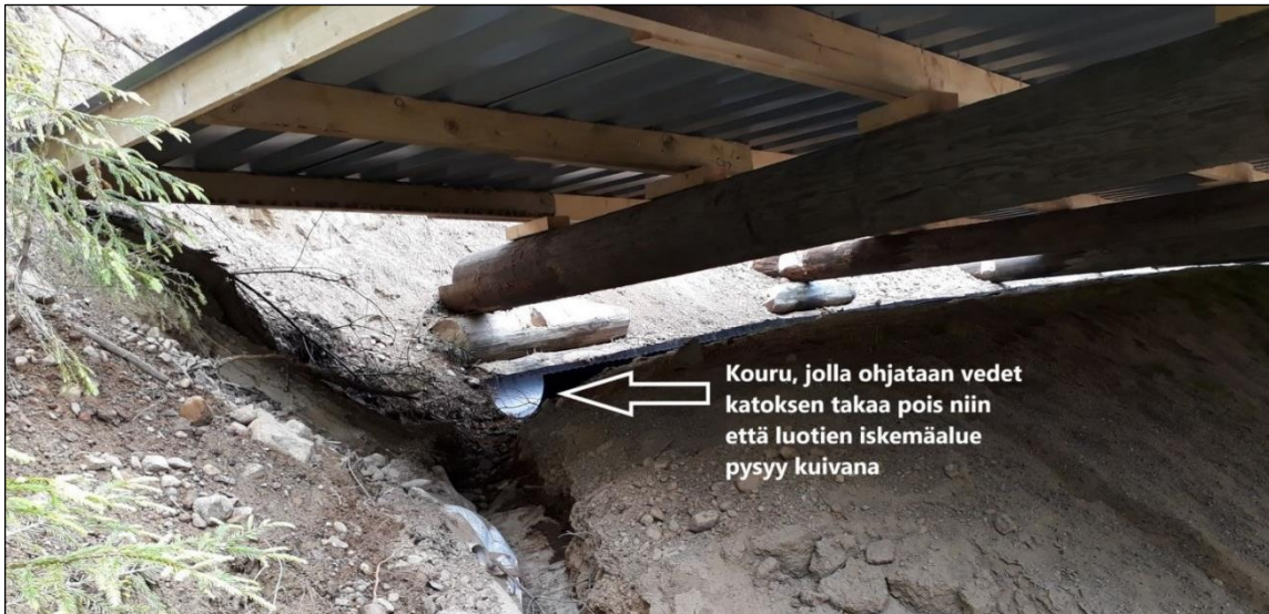
Kuva 3. Kuvassa 2 esitetyn hirviradan taustavallin katoksen vesien johtaminen siten, etteivät ne pääse kosketuksiin taustavallin iskemäalueen kanssa.
