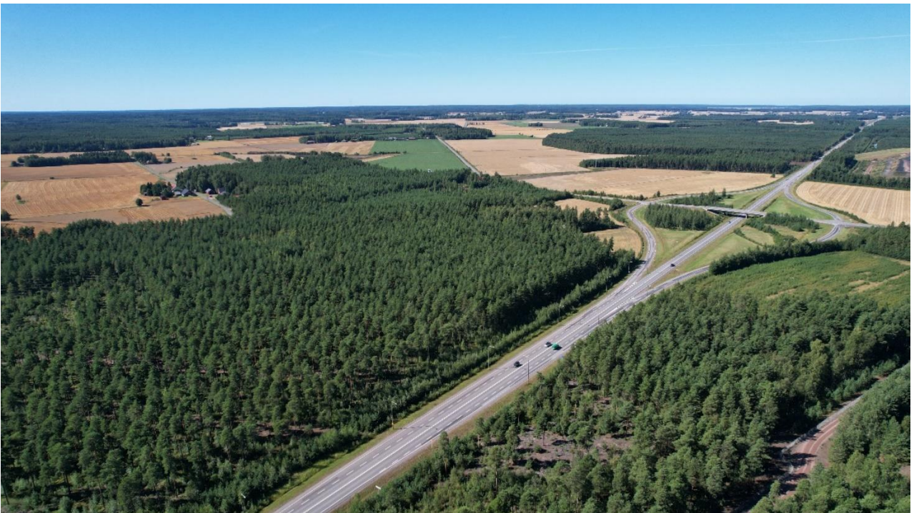
Valtatien 2 eteläpuoli on säilynyt varsin perinteisenä maalaismaisemana. Kuva otettu Torttilan eritasoliittymän kaakkoispuolelta kohti länttä.
