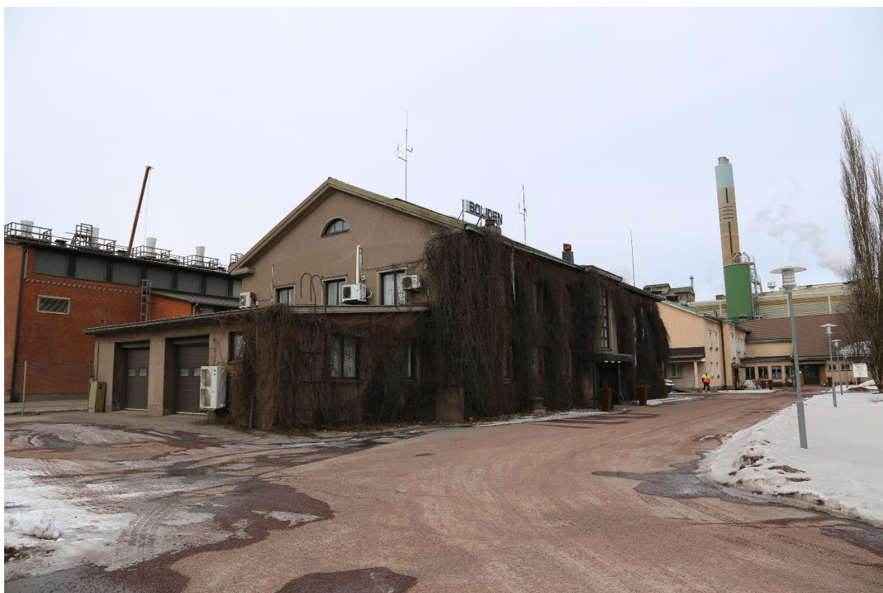
Suunnittelualueen rakennuskantaa Teollisuustie 1:ssä, pääkonttori/keskuskonttori (Boliden).
