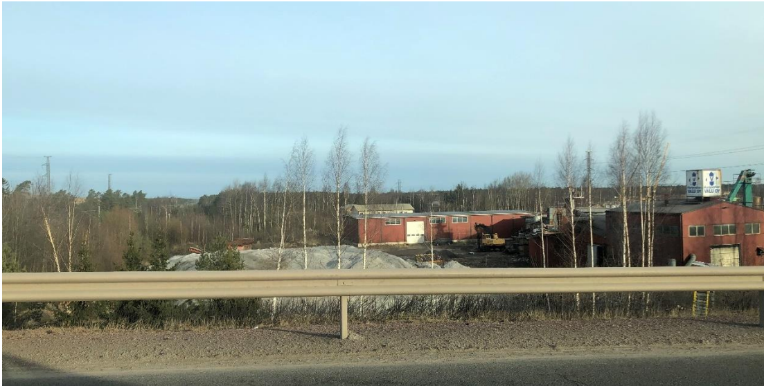
Kuva 1-9. Näkymä Torttilantieltä luoteeseen suunnittelualueelle. Sijoituspaikka sijoittuu kuvassa näkyvien valimorakennusten taakse (kuva: Jan Pettersson-Fernholm 31.3.2020).
